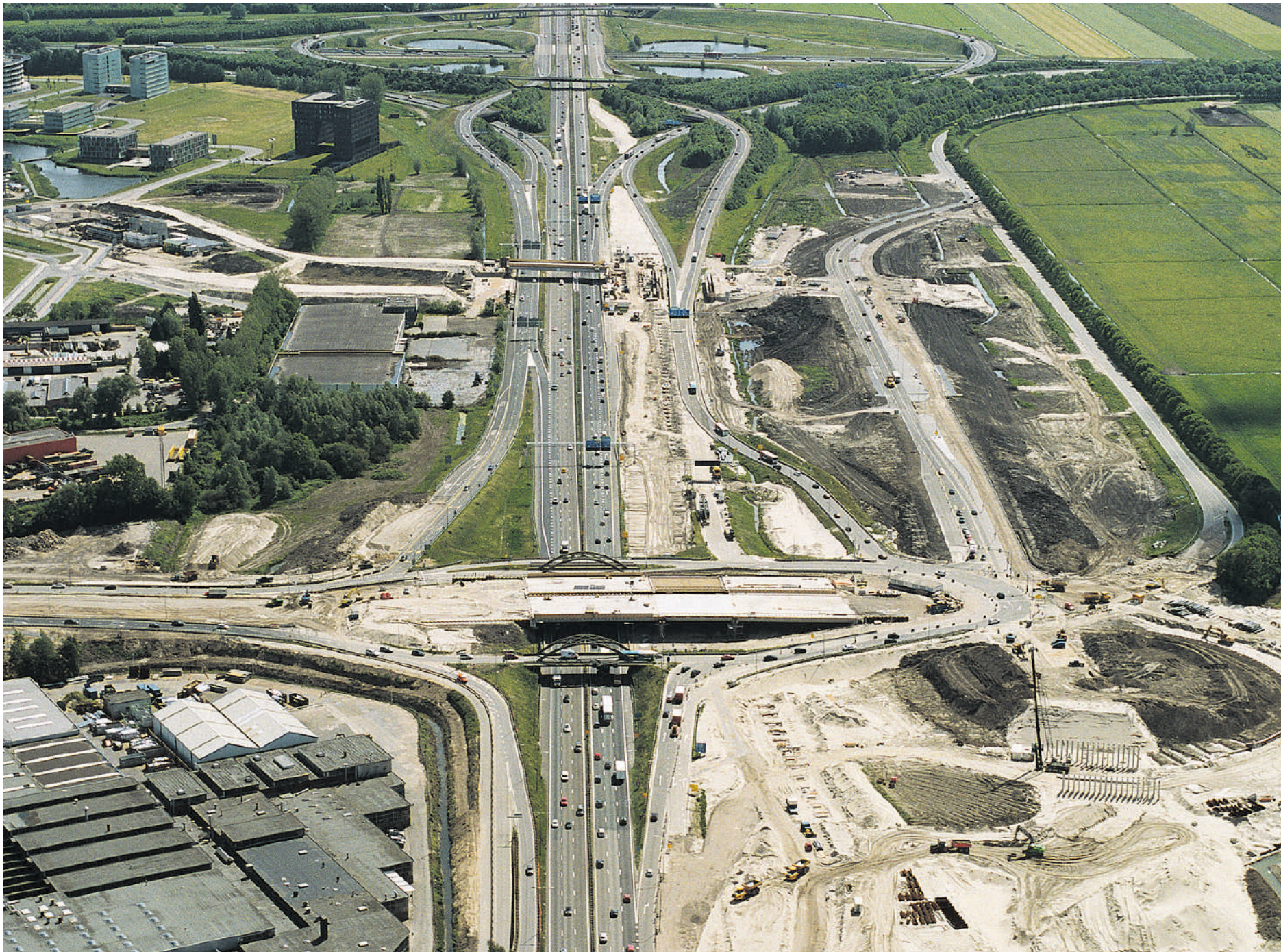
Twee karakteristieke boogbruggen zinken in het niet bij hun vervanger die tussen hen in wordt gebouwd. De twee worden volgende maand gesloopt. Foto Rijkswaterstaat
